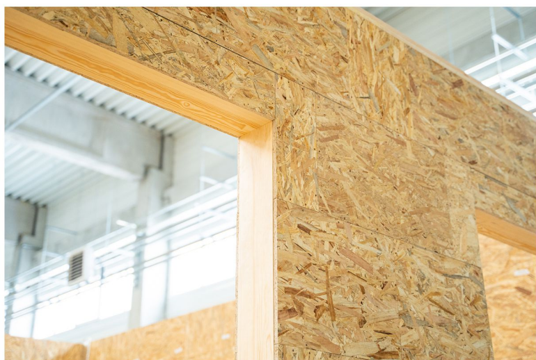
System BrickWood pozwala na prosty montaż drzwi i okien
