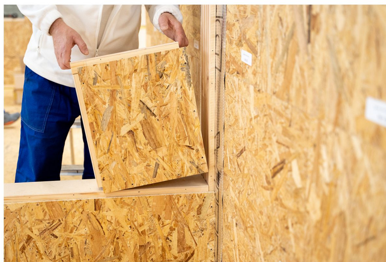
Instalacja ściany wewnętrznej
