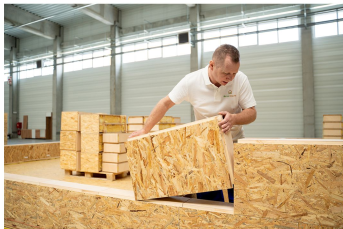
Proces montażu domu testowego
