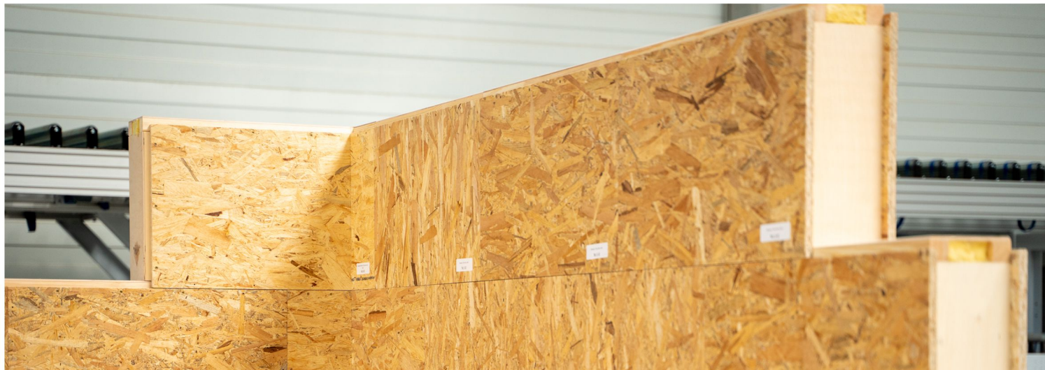
Częściowo zbudowana ściana zewnętrzna
