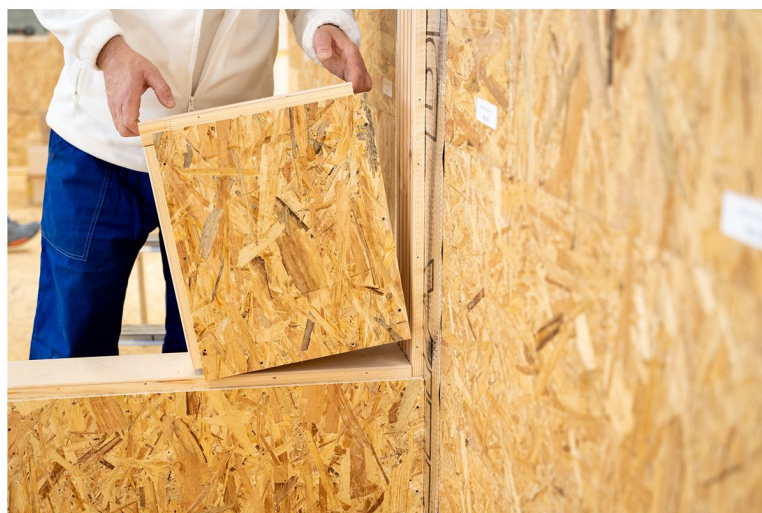
Instalacja ściany wewnętrznej
